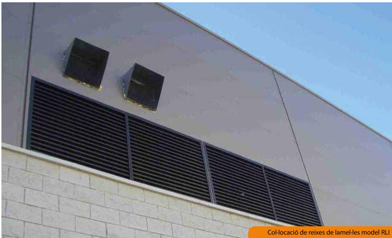
Col·locació de reixes de lamel·les model RLT
