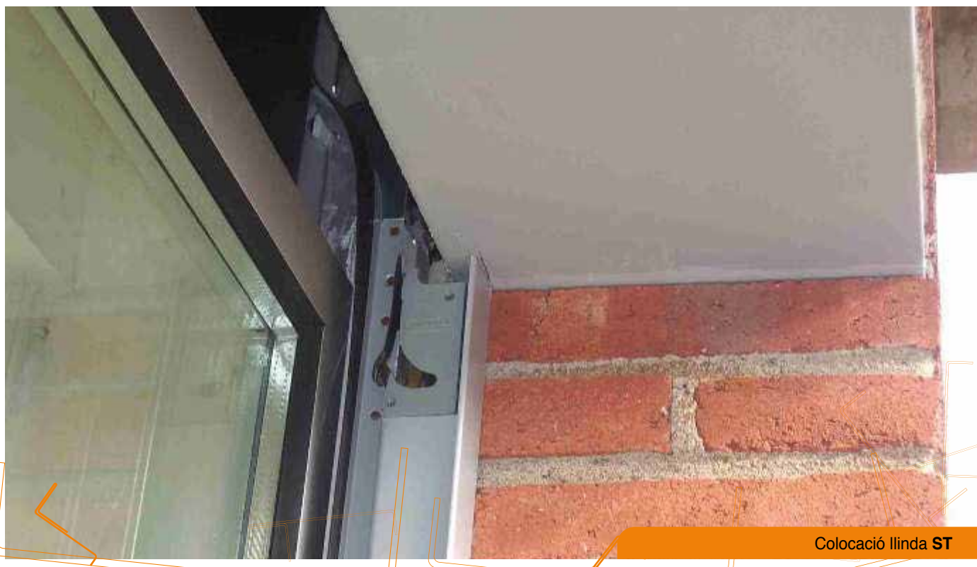
Colocació llinda ST
