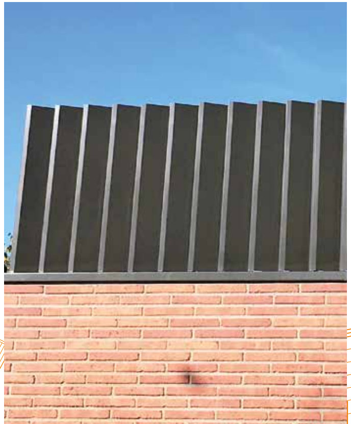
Col·locació de tancament exterior xapa perforada
