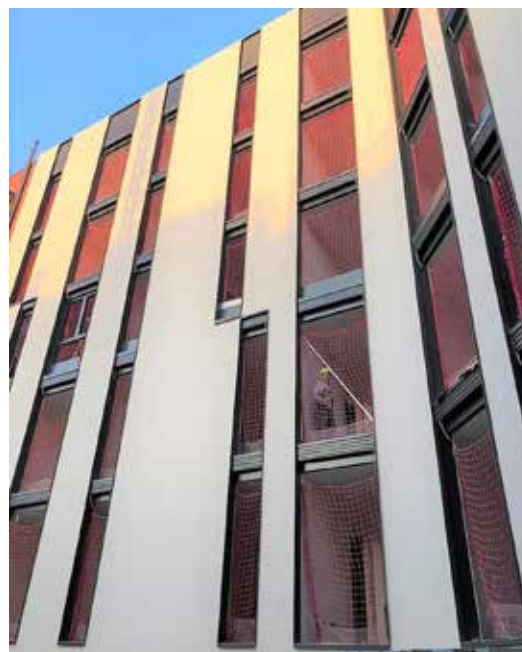
Enmarcs perimetrals compostos en columna
