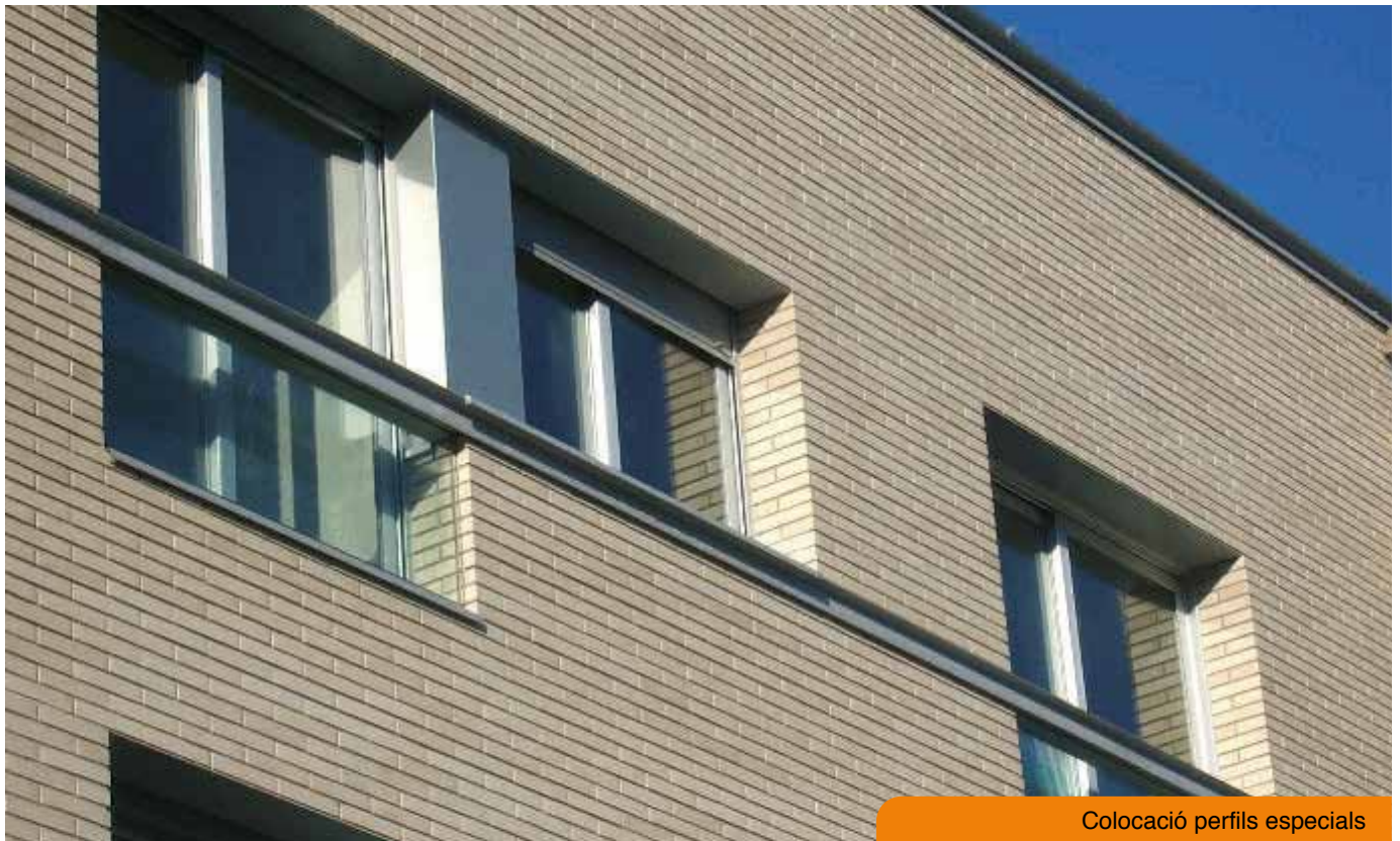
Colocació perfils especials
