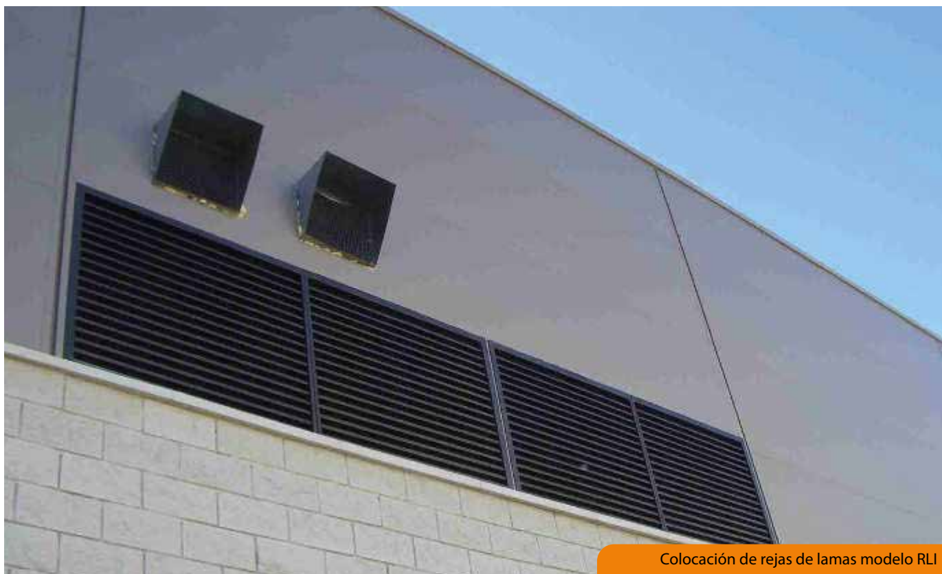
Colocación de rejas de lamas modelo RLT
