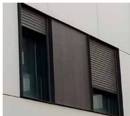
Marcos perimetrales con forro
