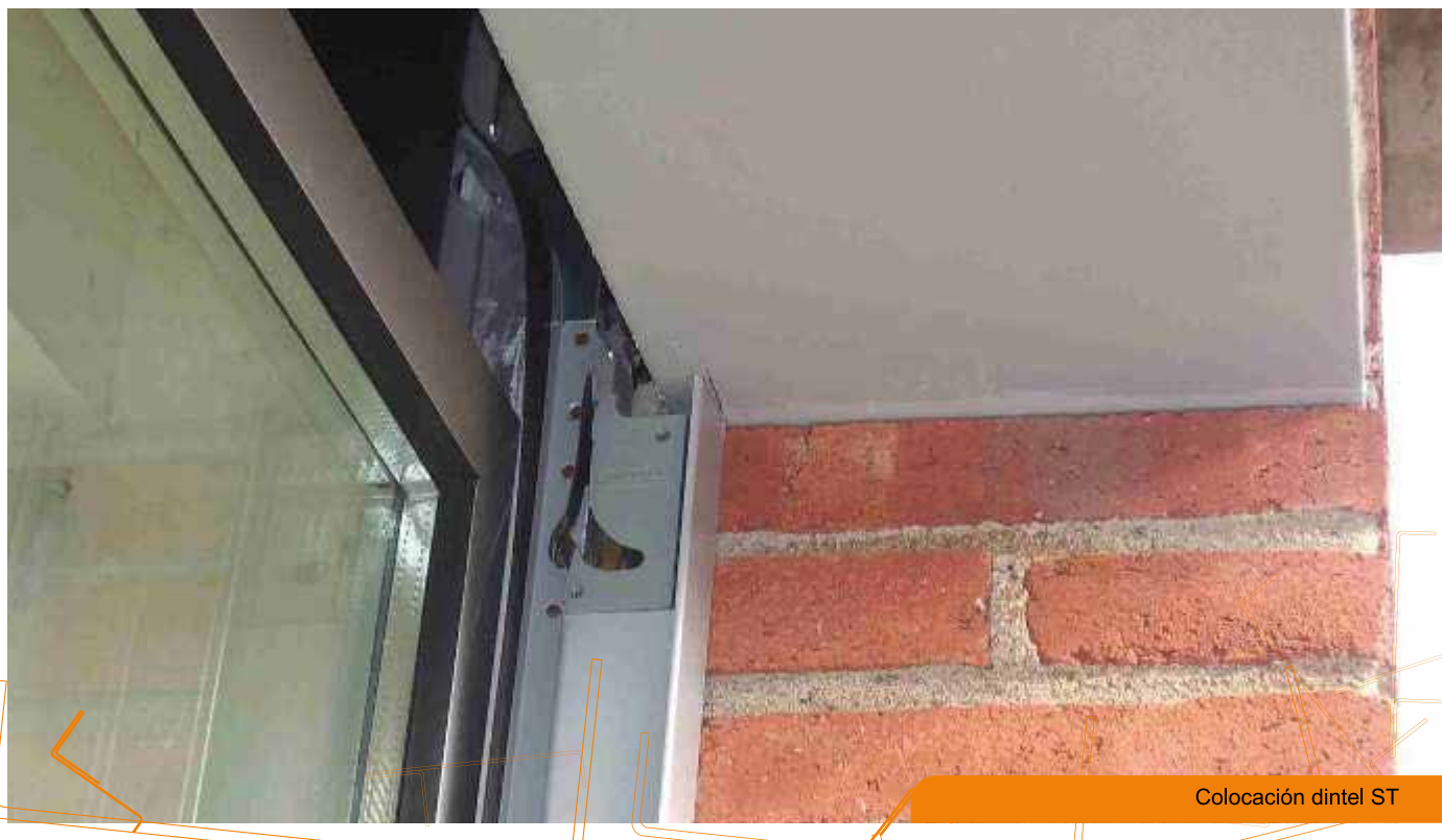
Colocación dintel ST
