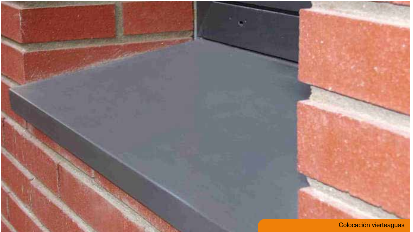
Colocación vierteaguas, jamba y mechones
