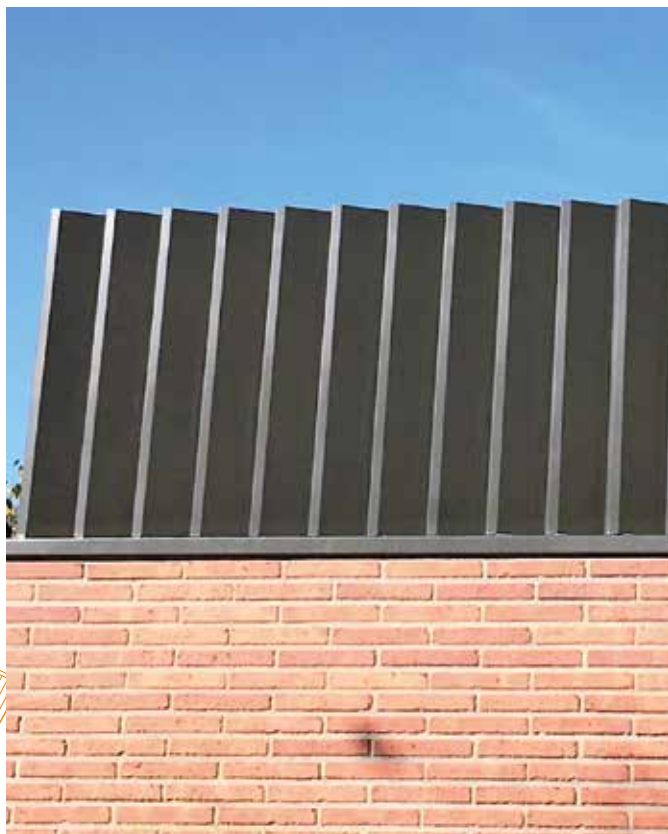
Colocación cerramiento exterior chapa perforada
